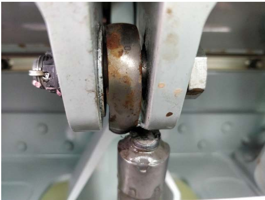
Chape de tige cisailée avec corrosion visible (2)
