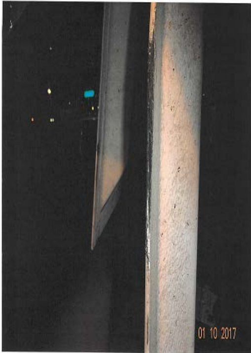
Zone de la porte du train d'atterrissage principal droit présentant de l'usure - Usure sur la porte du train d'atterrissage – profil
